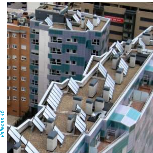
Detalle de fachada de colectores solares mediante tubos de vacío que aprovechan la energía solar
